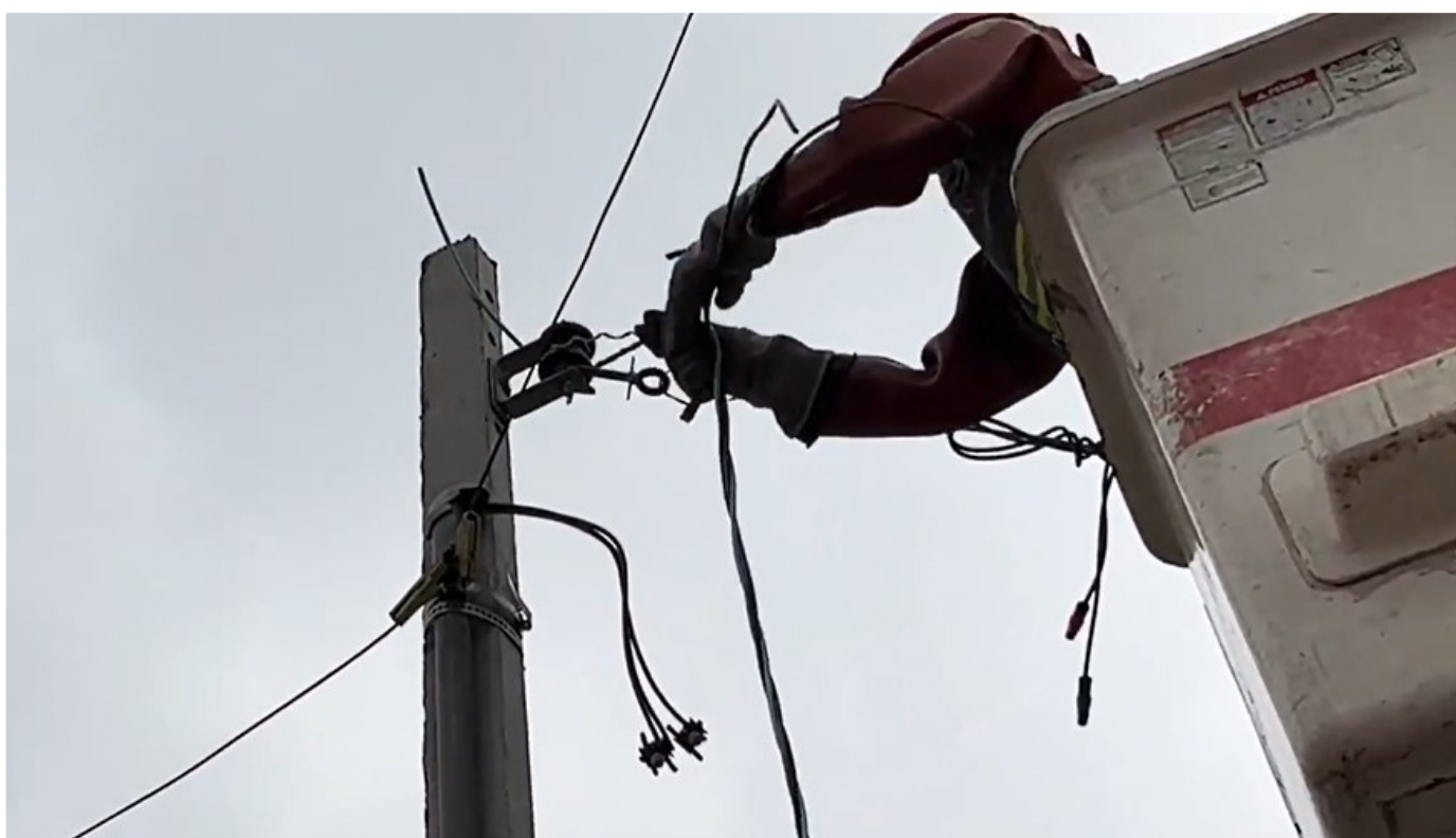
Figura 11 – Encabeçamento do novo ramal no isolador que foi liberado
