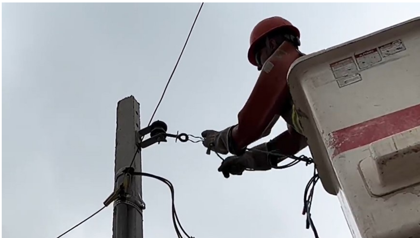
Figura 10 – Transferência do ramal de conexão a ser substituído para o gancho de ancoragem
