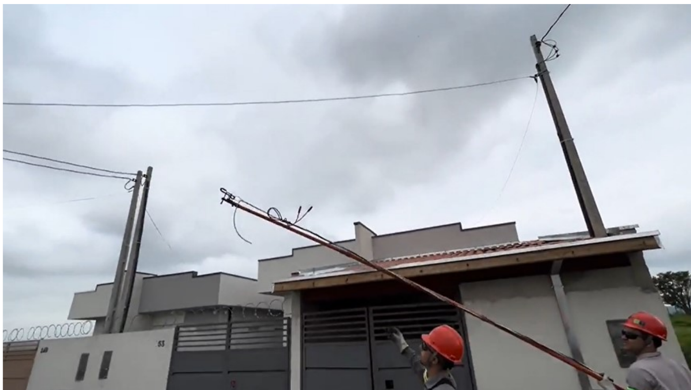
Figura 17 – Descida do ramal de conexão preso ao gancho fixado à vara de manobra
