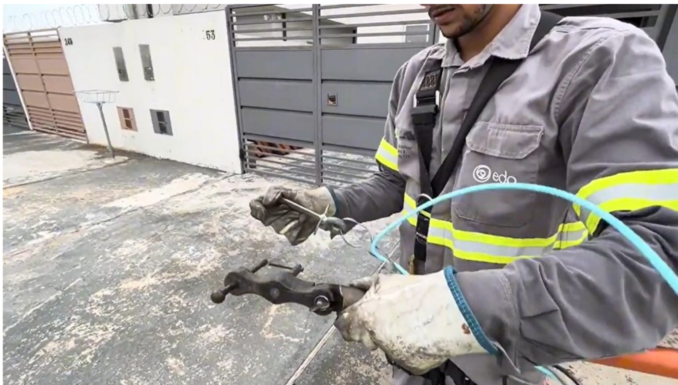
Figura 19 – Detalhe do gancho sendo desengatado
