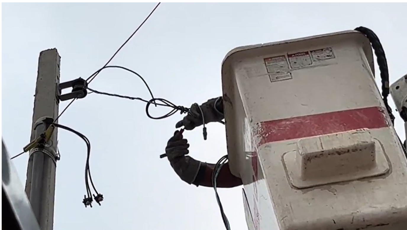
Figura 8 – Detalhe das pontas dos jumpers sendo isoladas
