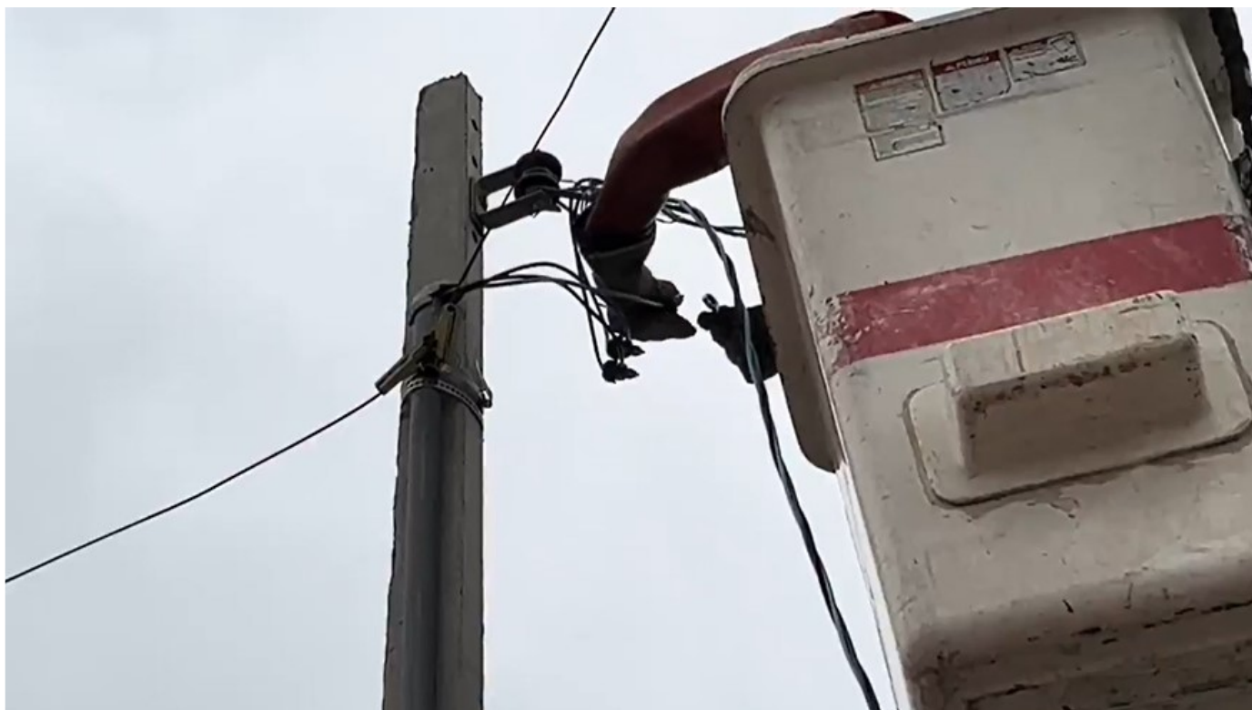
Figura 12 – Conexão entre o novo ramal de conexão e o ramal de entrada do cliente
