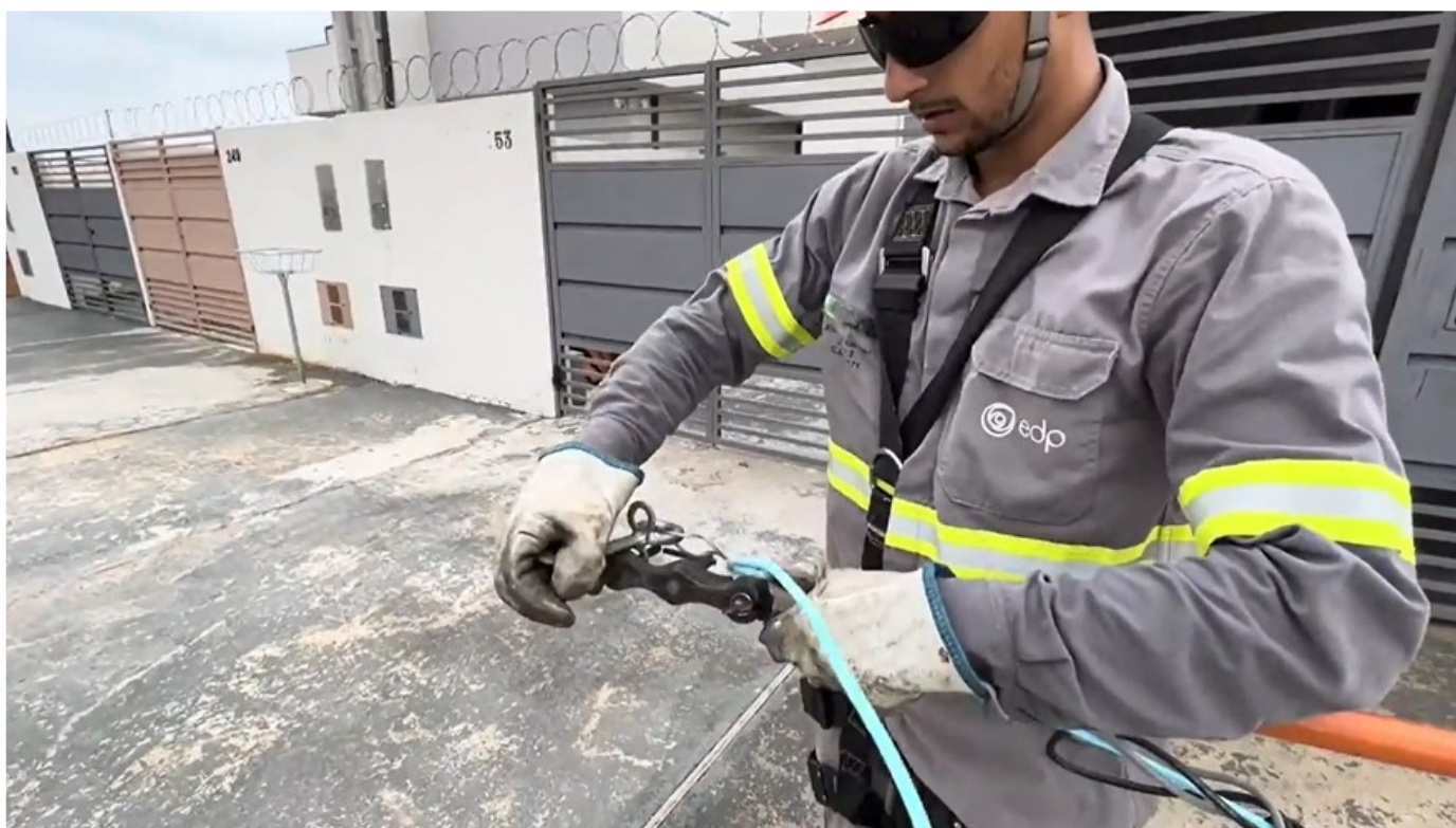
Figura 18 – Detalhe do gancho chegando em segurança até as mãos do executor
