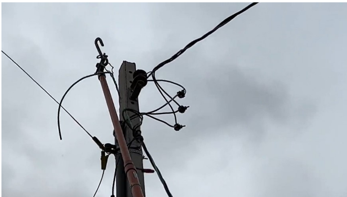
Figura 16 – Detalhe do gancho sendo removido e preso ao dispositivo antiqueda
