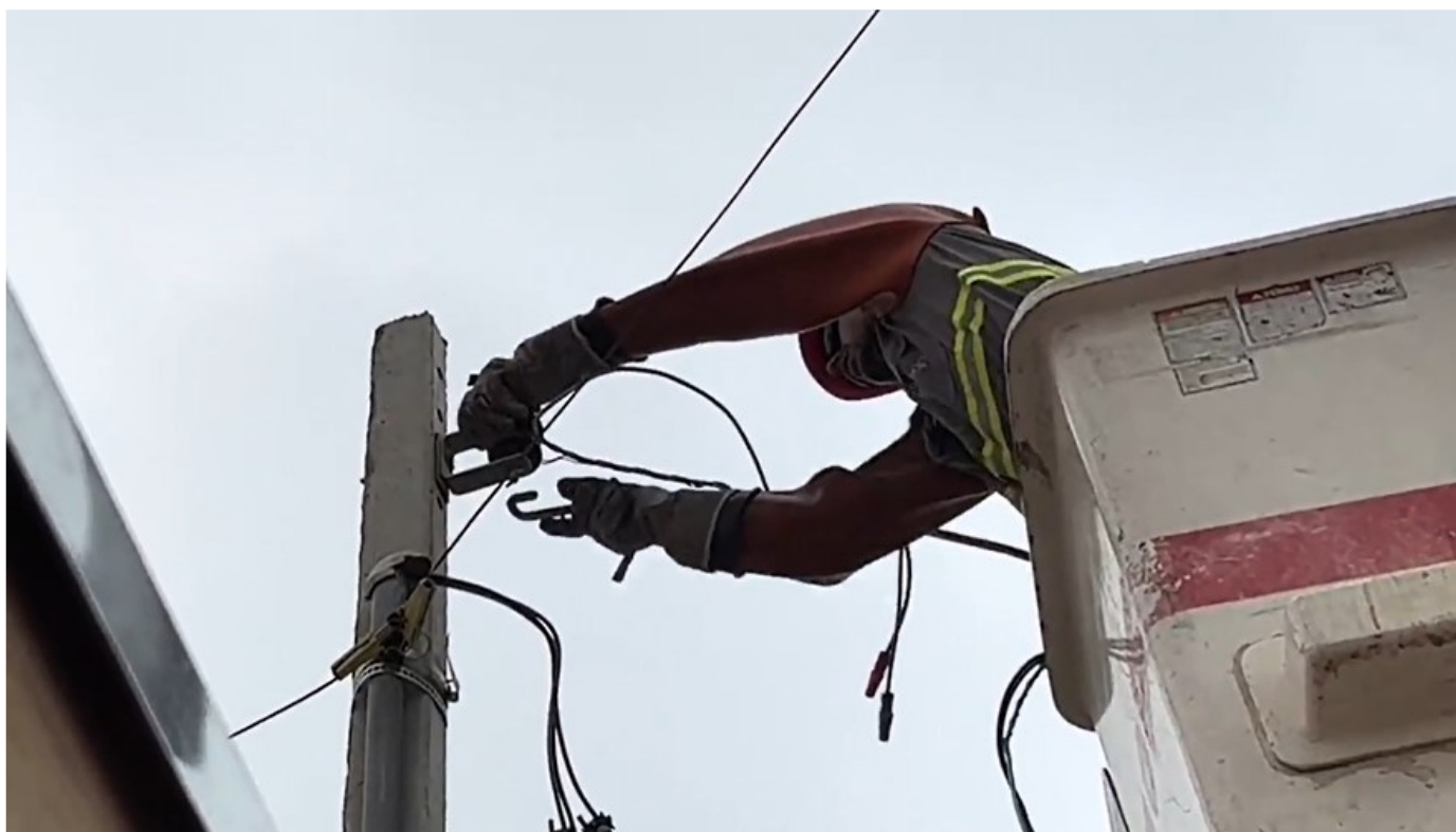
Figura 9 – Detalhe da instalação do gancho de ancoragem por baixo do isolador roldana
